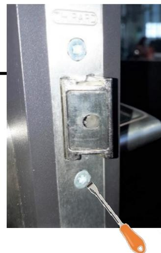
Sur ce type de serrure, la sortie du pêne est réglable à l'aide d'un tourne vis plat.
