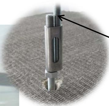
La tige filetée de 6 est fixée sous la dalle béton (ou poutre), pour supporter la charge des portes coulissantes.
