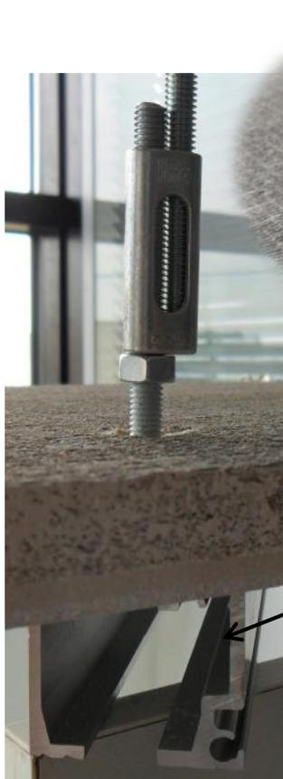
La tige filetée de 6 est fixée sous la dalle béton (ou poutre), pour supporter la charge des portes coulissantes.
