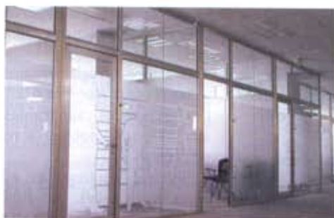
Cloison H5 Transparence. Bureaux Crédit Mutuel. Réalisation 2008. (Doc. HOYEZ)
